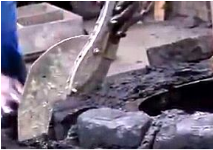
De kernwand wordt laag voor laag opgebouwd.
